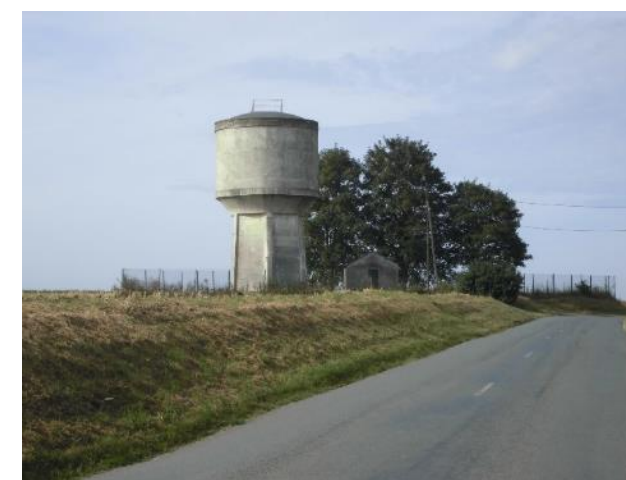
Figure 43 : Vue du château d'eau de Fontaine-lès-Croisilles
