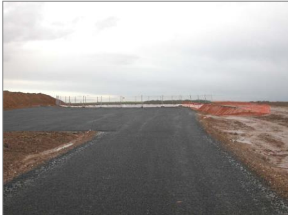
Figure 11 : Zone de grutage aménagée ou plateforme
