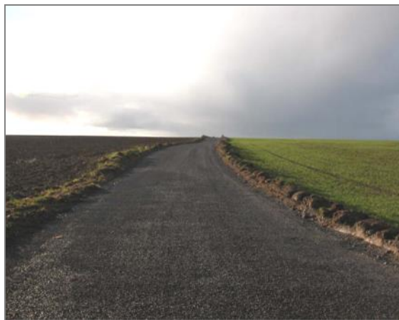
Figure 12 : Rénovation d'un chemin d'accès
