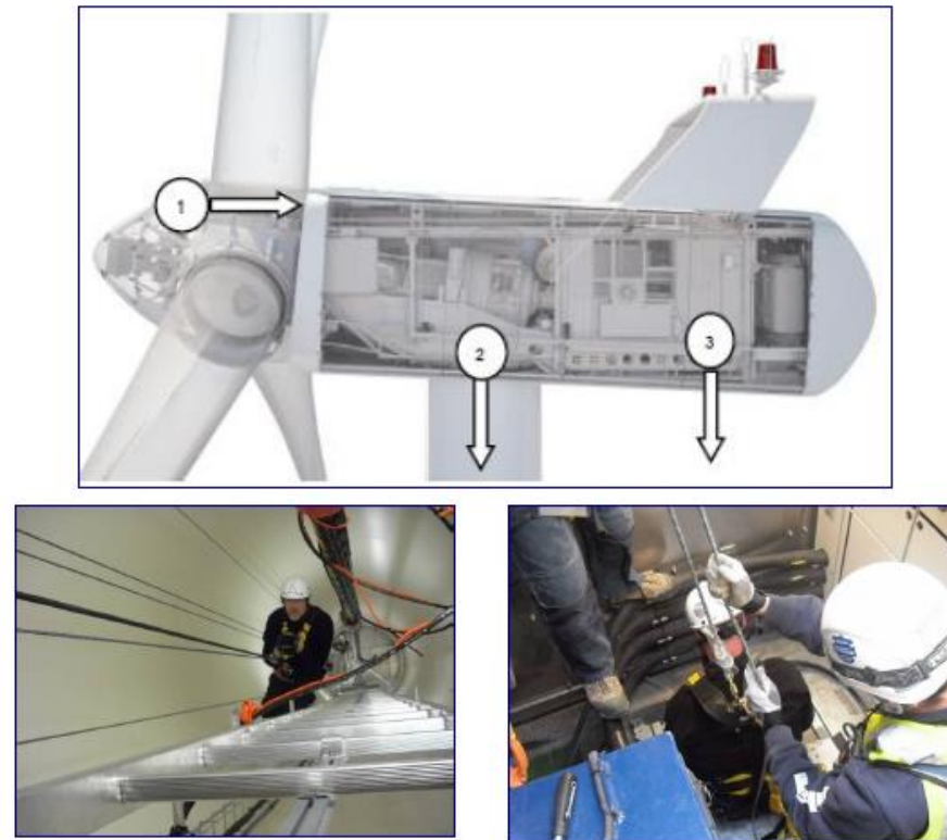
Figure 30 : Exemple d'évacuation et de sauvetage
